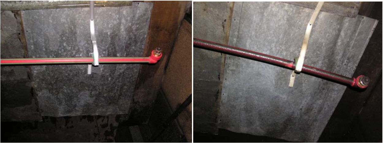
Рисунок ПД5 – Состояние трубы D_{\text{наруж}} 32 мм до и после испытаний (максимальная температура пожара (360-500) °С)
