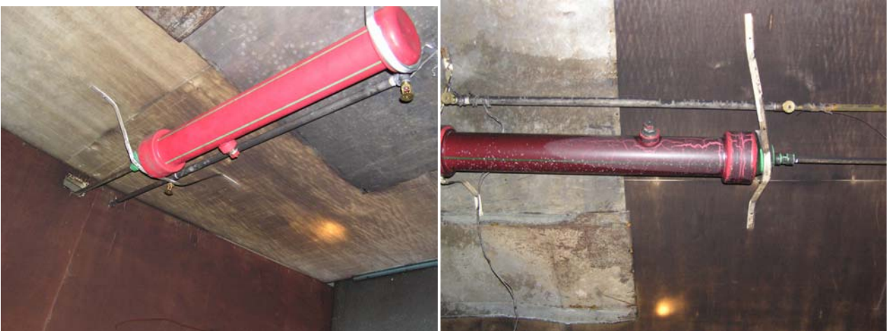
Рисунок ПД6 – Состояние трубы D_{\text{наруж}} 125 мм до и после испытаний (максимальная температура пожара (340 - 500) °С)
