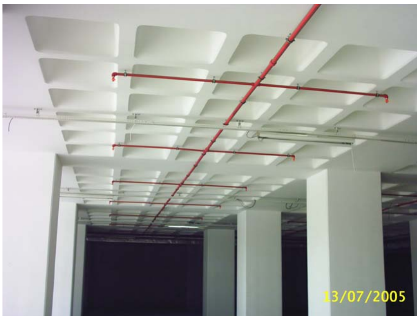
Рисунок 4.1 – Пример монтажа трубопроводов
